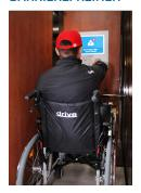
Bestehende Notrufsysteme in Aufzügen können in wenigen Stunden auf das VIEW-System umgerüstet werden. Das intelligente, kameragestützte System erkennt Notfälle sofort. So kann von der Notrufzentrale umgehend eingeschritten und Fehlalarme und zusätzliche Kosten verhindert werden. VIEW ist speziell für die Bedienung von physisch beeinträchtigen Menschen optimiert. Im Falle einer Störung geht das System auf die jeweilige Einschränkung ein. Über die Displaytechnologie werden relevante Informati-
